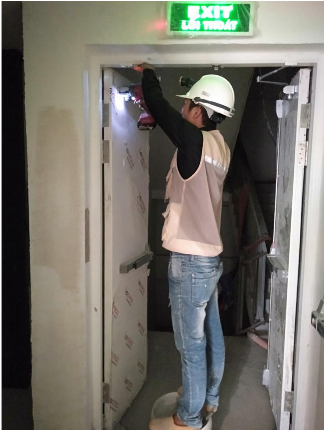
Hình 7: Công tác chỉnh sửa tay co sau thời gian sử dụng
