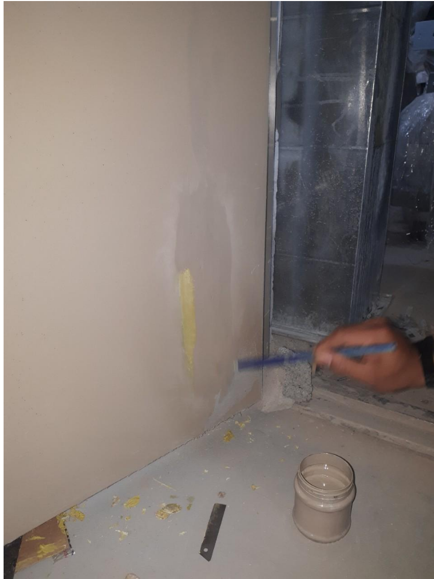
Hình 5: Công tác sơn thí điểm vị trí sơn bong tróc
