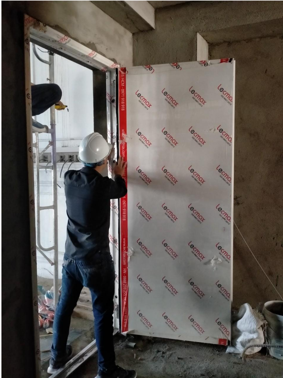
Hình 3: Công tác căn chỉnh bản lề cửa chống cháy
