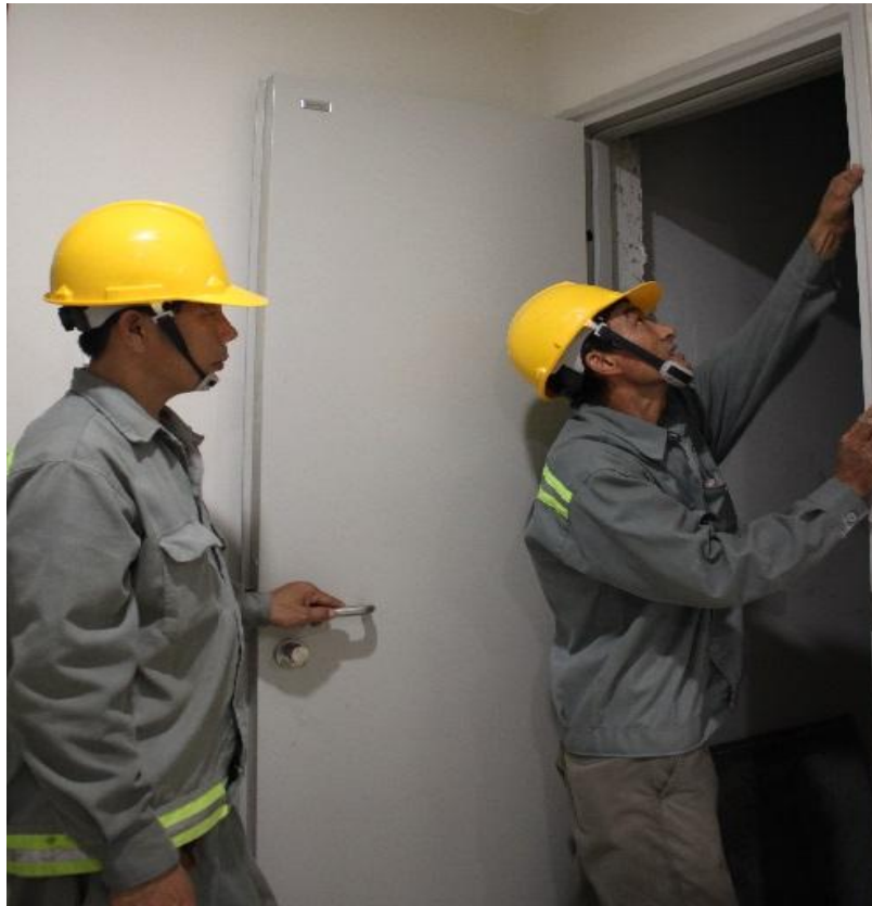
Hình 1: Công tác cân chỉnh, gia cố khung cửa
