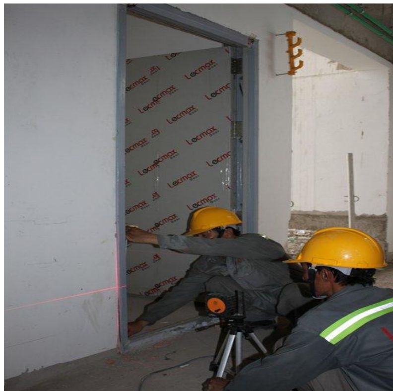
Hình 1: Công tác cân chỉnh, gia cố khung cửa
