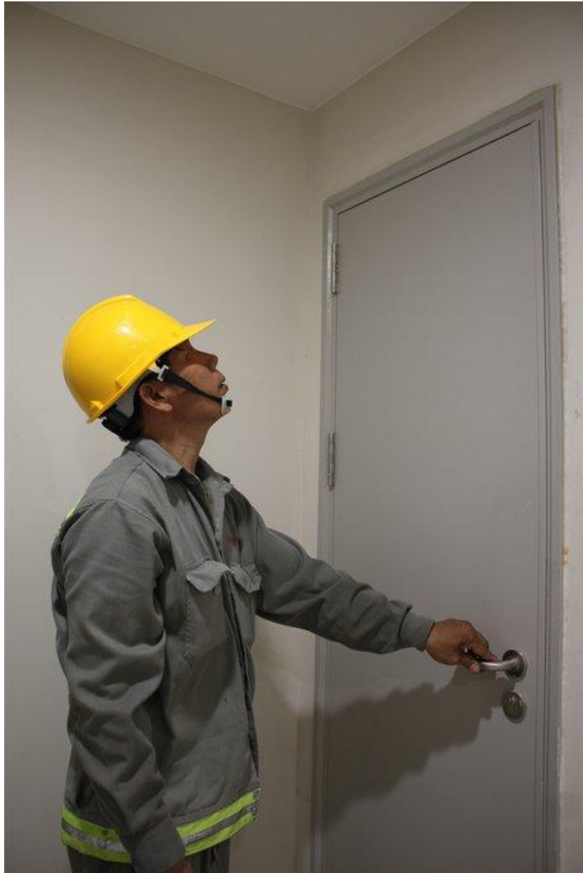
Hình 6: Công tác kiểm tra khóa sau thời gian sử dụng
