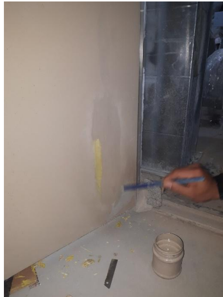
Pha chế dung dịch sơn và xử lý cửa bị bong tróc sơn
