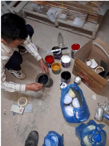
Pha chế dung dịch sơn và xử lý cửa bị bong tróc sơn
