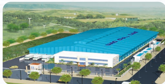
Nhà máy UAC - Đà Nẵng UAC factory - Da Nang
