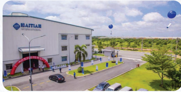
Nhà máy HuaYuan Việt Nam Huayuan (Vietnam) Factory
