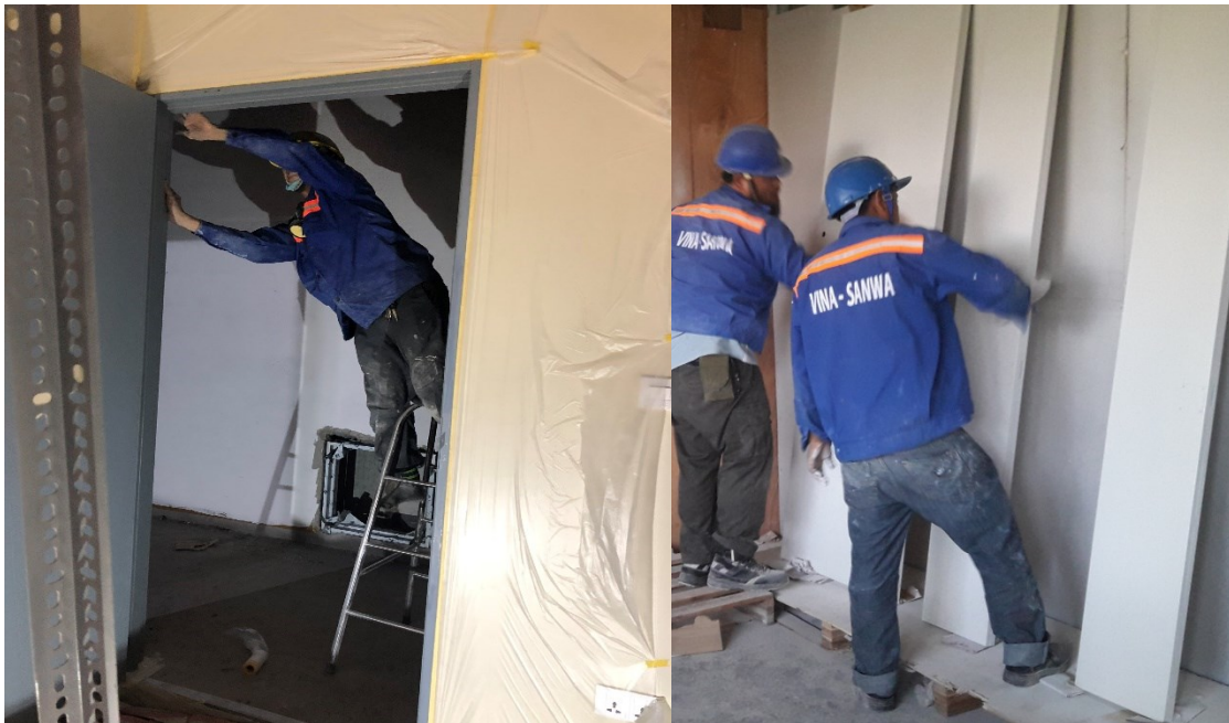
Cleaning surface door frame and leaf / Vệ sinh bề mặt khung và cánh
