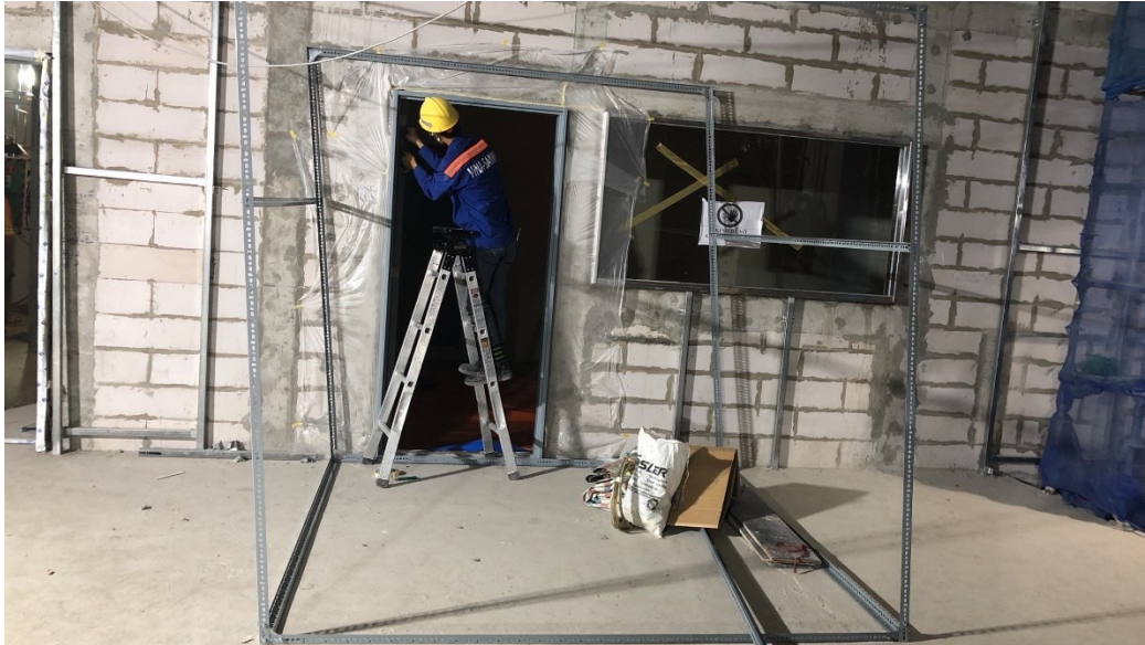
Protect wall by pvc sheet / Bảo vệ tường bằng tấm pvc
