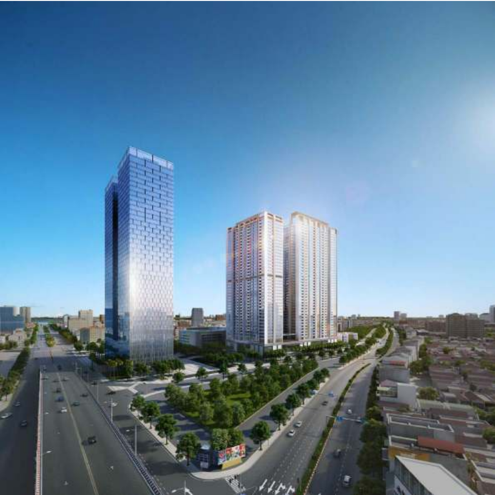
Vinhomes Metropolis - Hà Nội - Cung cấp và lắp đặt cửa thép chống cháy - Quy mô: 35.000 m 2
