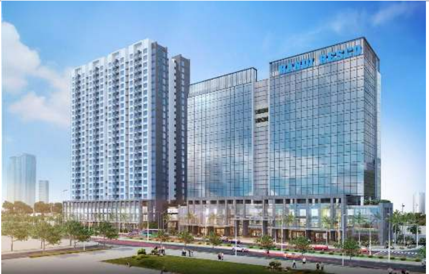
Handiresco Tower - Hà Nội - Cung cấp và lắp đặt cửa ABS thông phòng, cửa chống cháy Quy mô: 2.410 m 2
