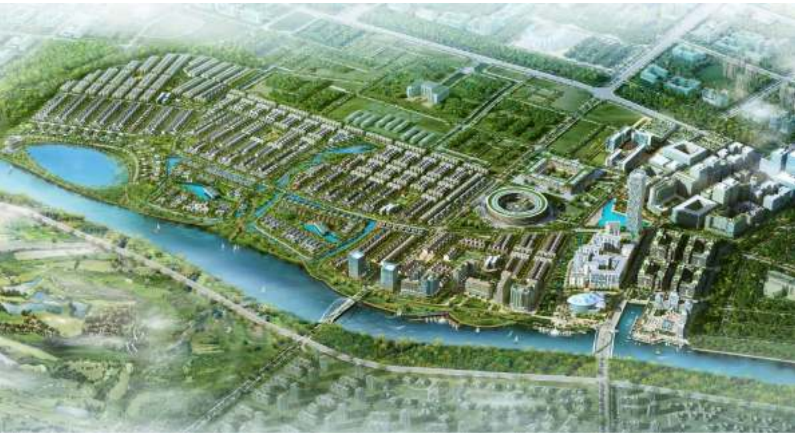
FPT City - Đà Nẵng - Cung cấp và lắp đặt cửa thép chống cháy kỹ thuật Quy mô: 1.810.000 m 2
