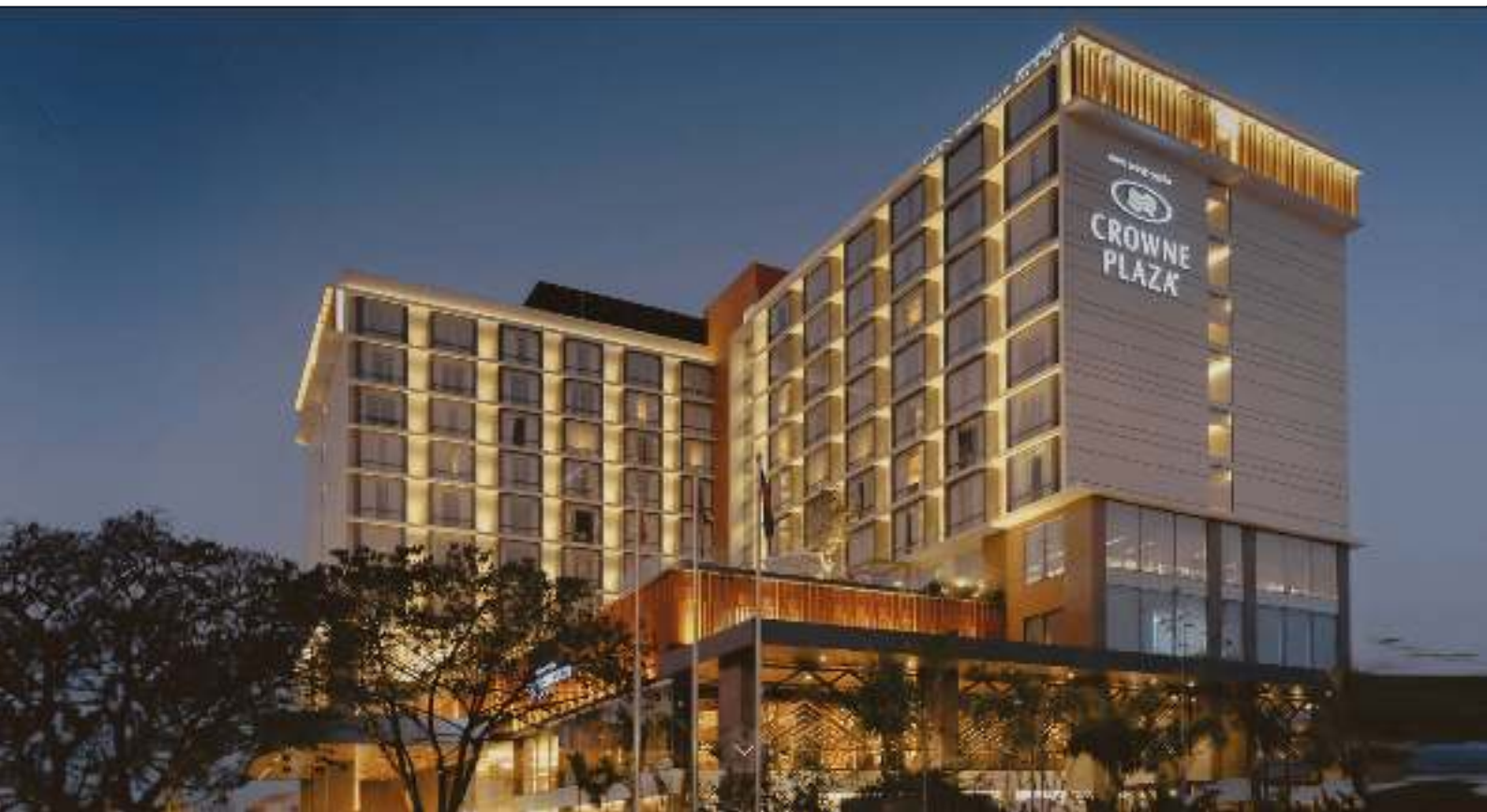
Crowne Plaza Hotel - Laos - Cung cấp và lắp đặt cửa thép chống cháy, cửa cuốn Quy mô: 20.000 m 2
