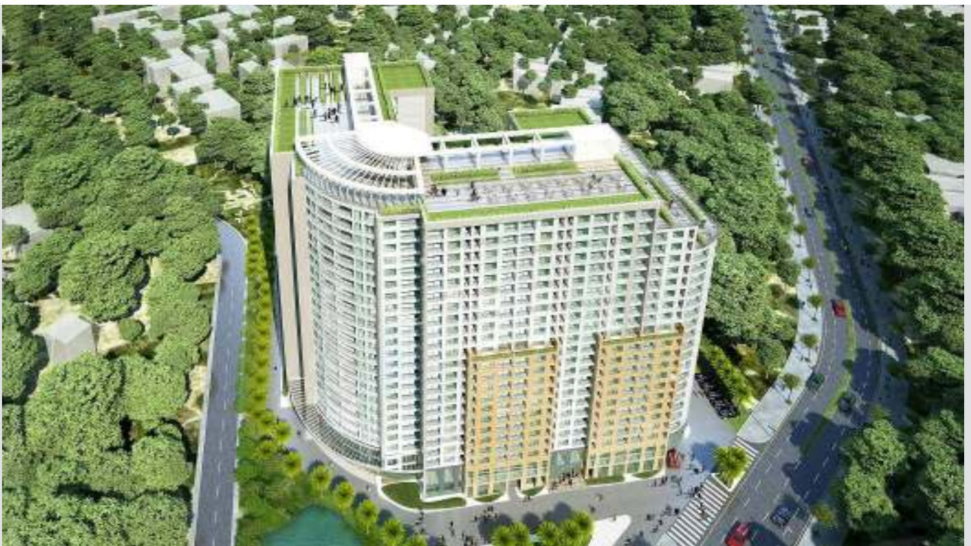
T&T Riverview - Hà Nội - Cung cấp và lắp đặt cửa kính căn hộ, cửa thép chống cháy Quy mô: 8.850m 2
