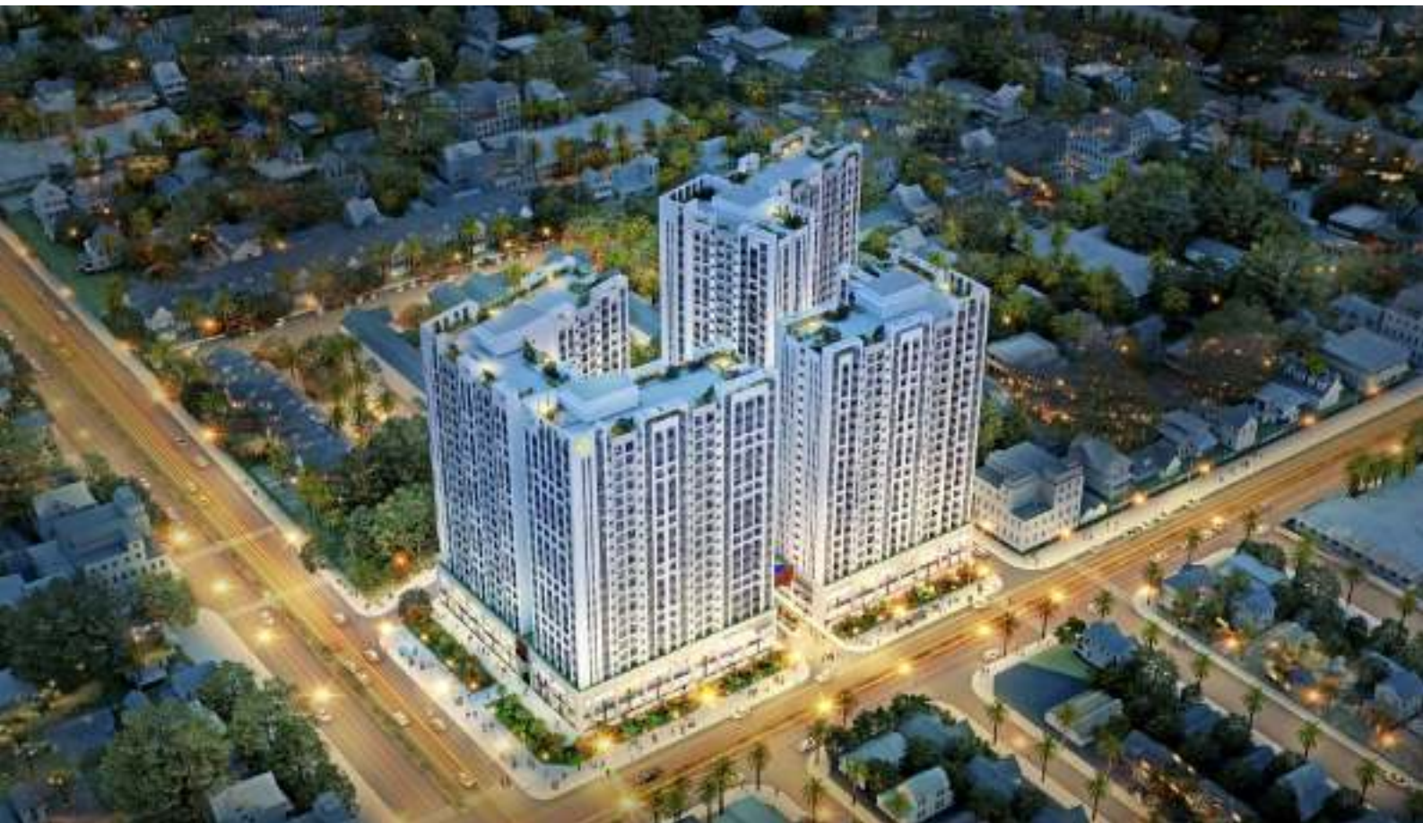
Richstar Tân Phú - TP.HCM - Cung cấp và lắp đặt cửa ABS thông phòng - Quy mô: 30.000 m 2
