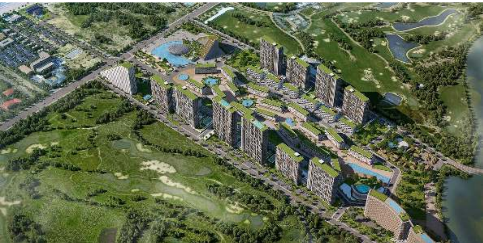
The Empire COCOBAY - Đà Nẵng - Cung cấp và lắp đặt cửa thép chống cháy kỹ thuật Quy mô: 310.000 m 2
