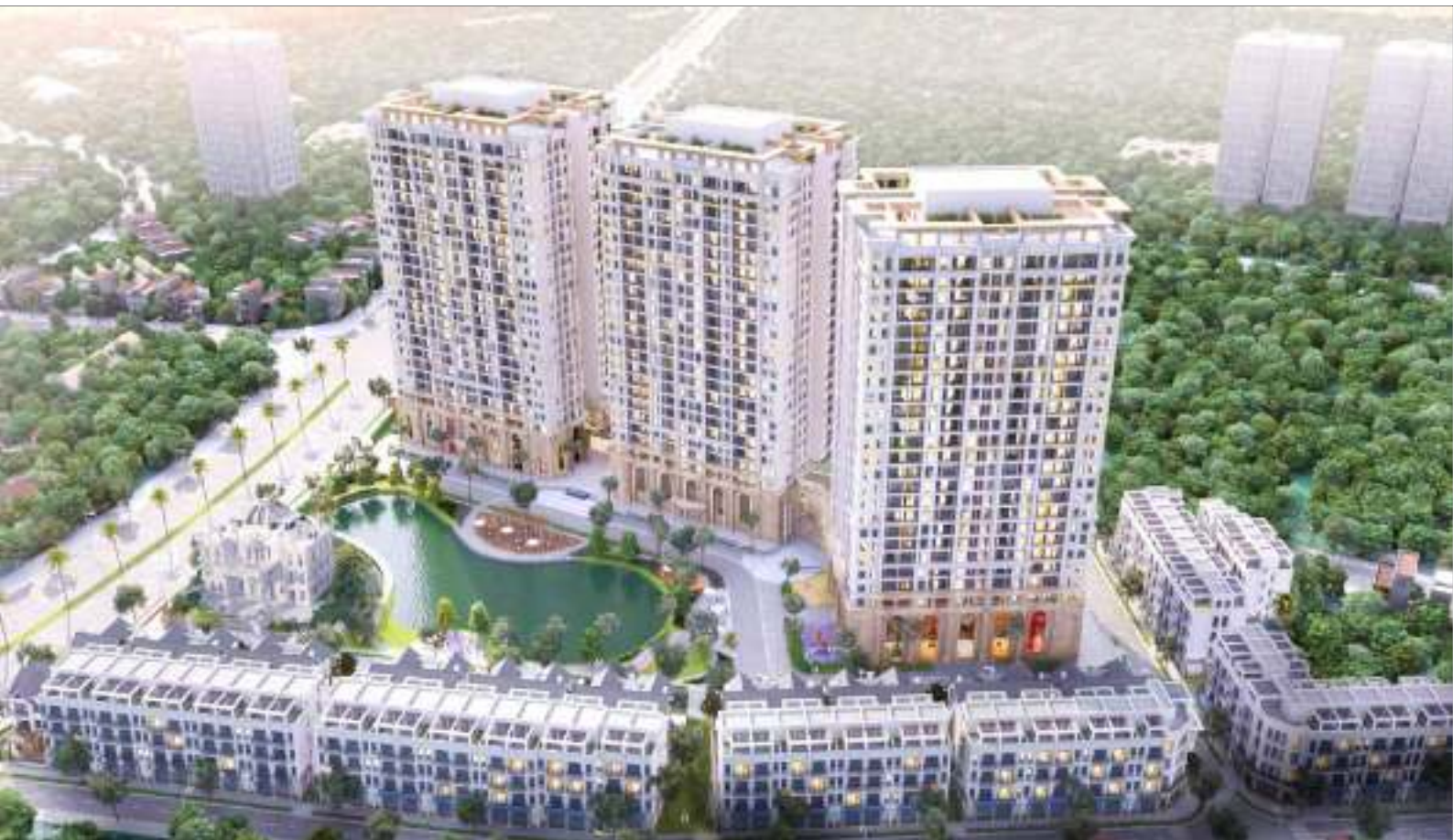
Hateco Apollo - Hà Nội - Cung cấp và lắp đặt cửa ABS thông phòng - Quy mô: 35.000 m 2
