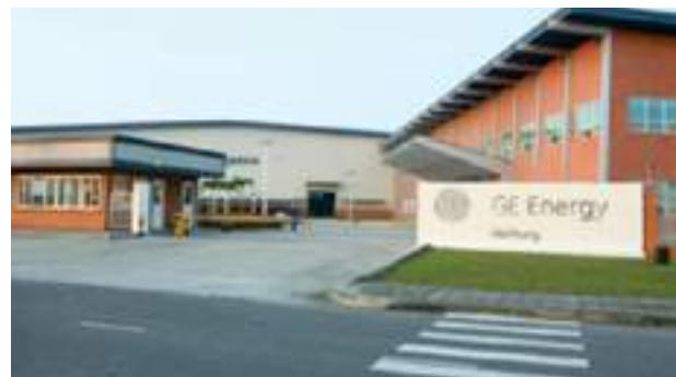
Nhà máy GE / GE Factory
